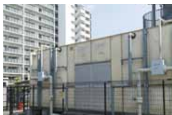
●タンク内の残量監視
